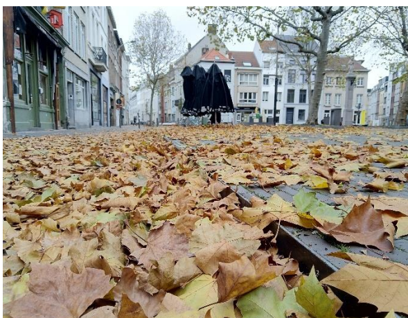
De verhoogde boord aan de zuidzijde vormt een risico voor valongevallen. De boord is niet duidelijk zichtbaar, zeker in de herfst wanneer de grond bedekt is met bladeren.
