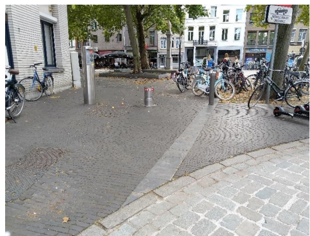
De toegang tot het plein (NW-zijde) oogt rommeling door slecht gestalde fietsen, brommers en deelsteps.
