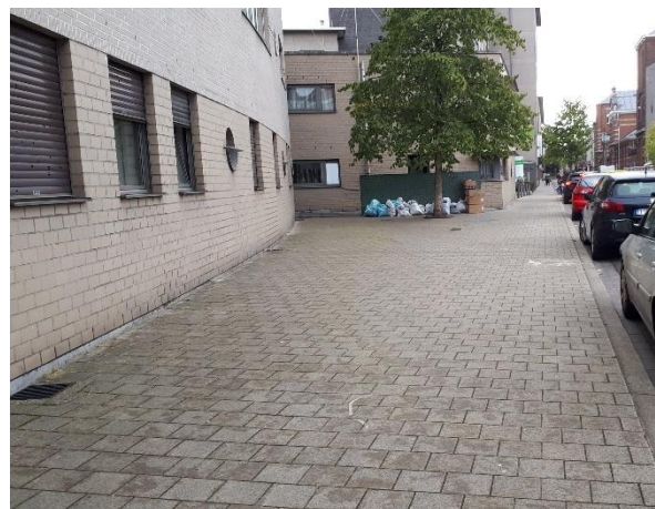
Een stuk voetpad in de Balansstraat. Ook hier biedt het voetpad voldoende ruimte voor
