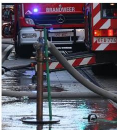
Hydrant tijdens het blussen
