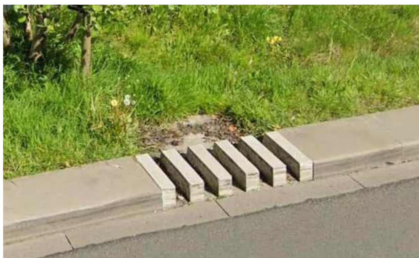
Waterpasserende boordsteen richting middenberm
