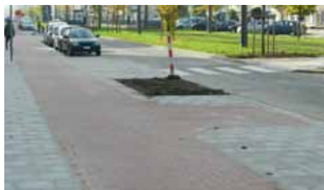
Fietspad Ruggeveldlaan Noord
