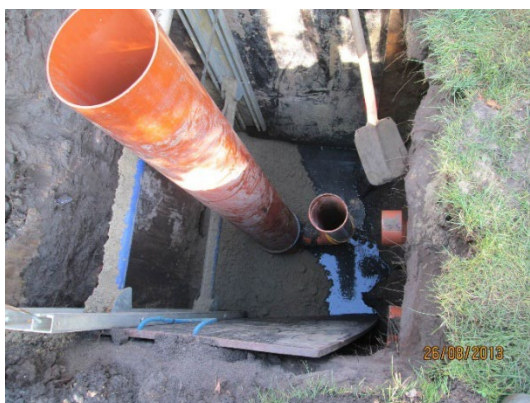
Ontvangstput bij een pilootstangboring
