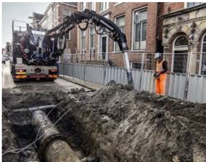
aanleg met grondzuigwagen
