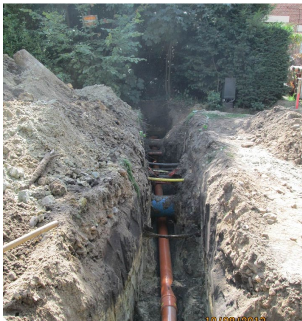
aanleg in open sleuf
