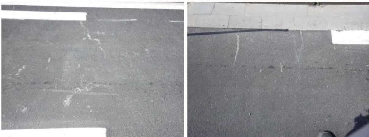
Figuur 5-7 Schade ter hoogte van het fietspad in het proefvak Decipave [B. Duerinckx – 15]
