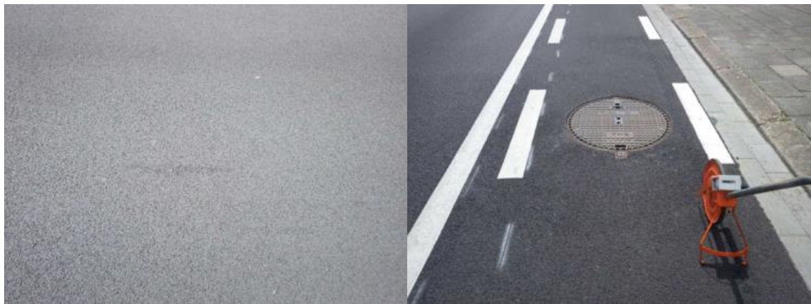
Figuur 5-5 (links) lichte rafeling op het proefvak Nobelpave – (rechts) open aspect rond de riooldeksels [B. Duerinckx – 15]
