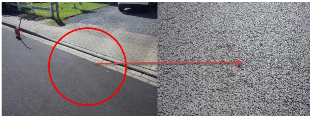
Figuur 5-12 Wringplekken ter hoogte van een oprit in het proefvak Micropave [B. Duerinckx – 15]
