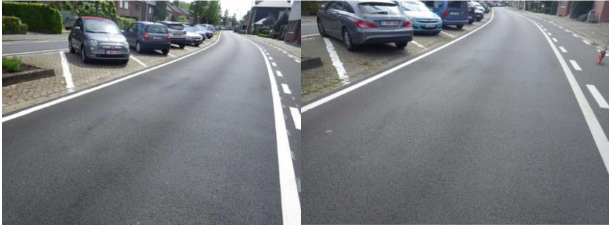
Figuur 5-6 Evolutie van de lichte rafeling in het proefvak Nobelpave (links) 2016 – (rechts) 2017 [B. Duerinckx – 15]
