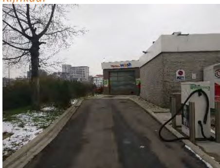
14. oprit carwash servicestation Total vanaf Dinantstraat
