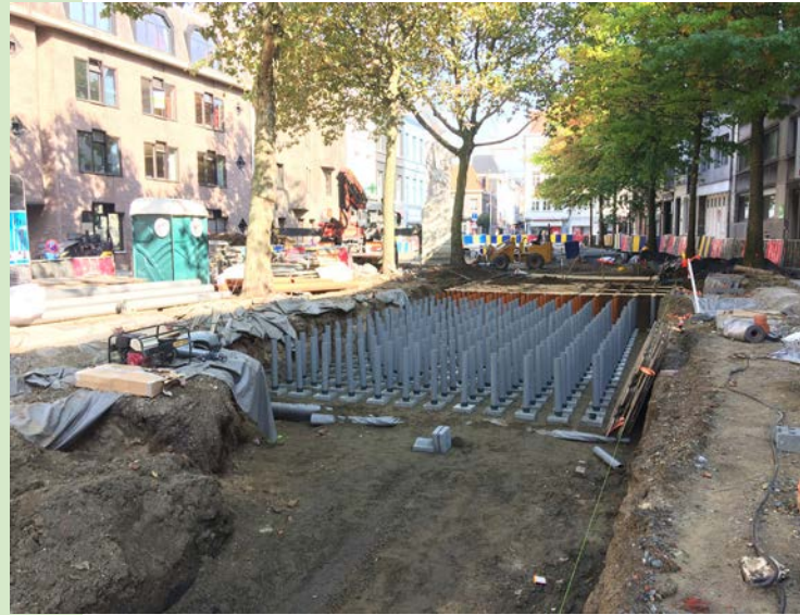
Situatie tijdens de heraanleg
