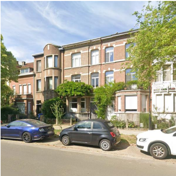
Figuur 2-3 Voorbeeld van gevelgroen ter hoogte van Ter Rivierenlaan 65. (Bron: Google maps, 2025)
