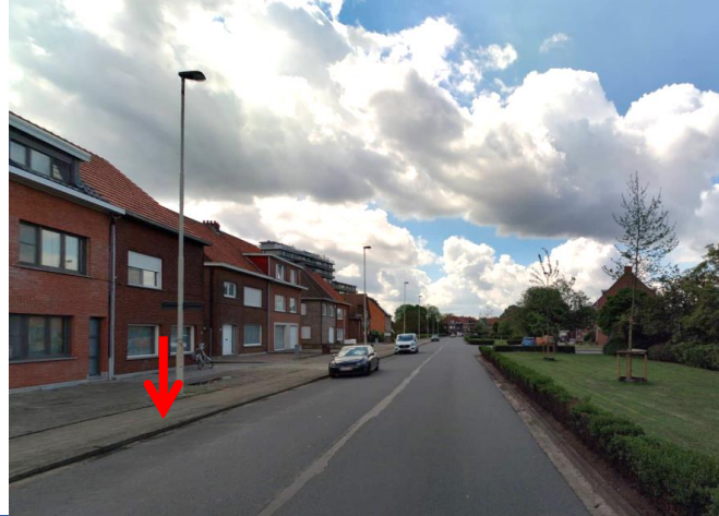
Rijweg met éénzijdig aanliggend fietspad
