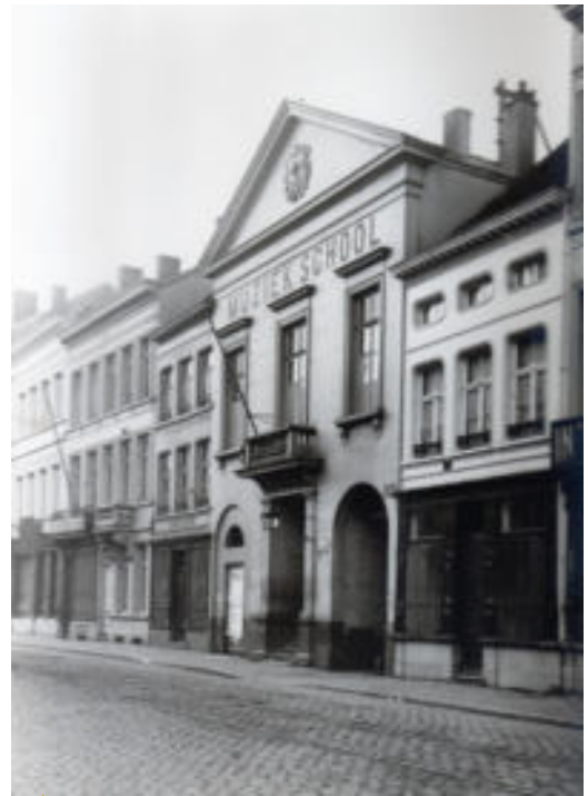
Foto uit ca. 1900 van het neoclassicistische “Reuzenhuis” op de Turhoutsebaan nr. 110. Het gebouw verrees op de plek waar ooit het dorpshuis (“de schuur van Borgerhout”, magazijn dat in 1832 werd afgebroken) heeft gestaan. Het “Reuzenhuis” deed achtereenvolgens dienst als eerste gemeentehuis van Borgerhout (1836-1890), al muziekschool en als Borgerhouts Heemmuseum. Op het balkon boven de hoofdingang stonden ooit, op de vooravond van de Borgerhoutse kermis, de vier Reuskens uitgesteld. Een volksgebruik dat helaas is verloren gegaan (van de Vijver 1972, Figuur 74), (Foto Gitschotelbuurschap vzw).
