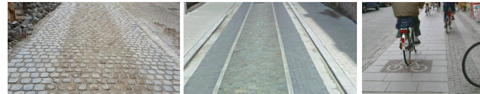
Links: Gezaagde kasseien aan de rand van de weg (Eilandje) Midden: 'Karrenspoor' (Coveliersstraat) Rechts: strook natuursteen in kasseivlak (Edegem)
