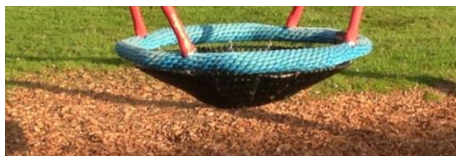
Schors valdempende ondergrond
