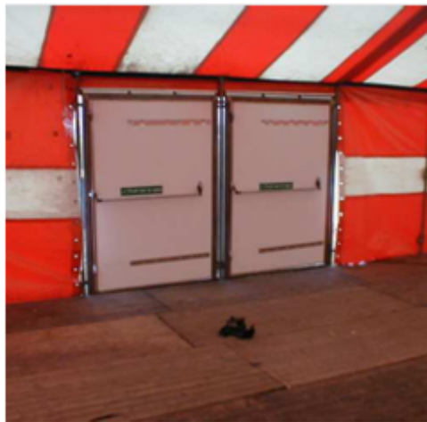
Voorbeeld hoe in een tent met zeildoekwanden ook een goede nooduitgang gemaakt kan worden
