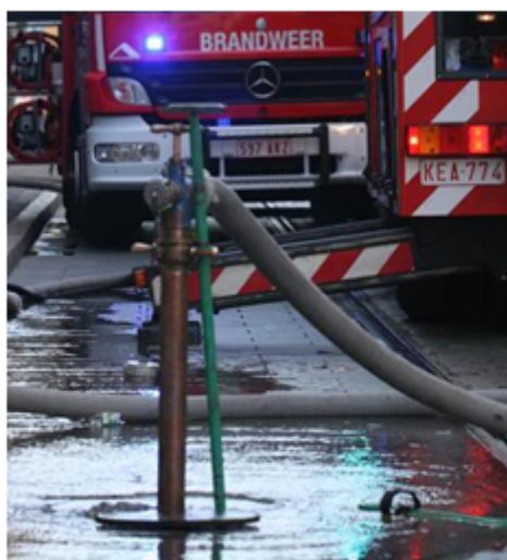
Hydrant tijdens het blussen
