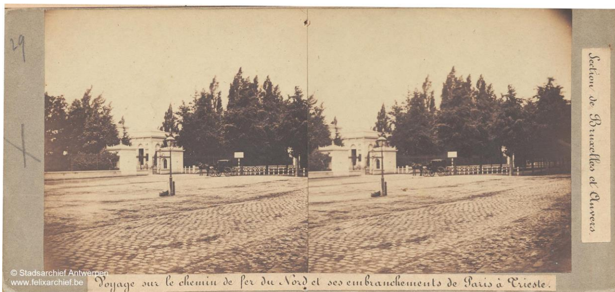
Afbeelding 6. Zicht op de Mechelsesteenweg en een glimp van het zomerlokaal, 1861. Foto gemaakt door Louis-Pierre-Théophile Dubois de Néhaut. Felixarchief, fotoverzameling losse foto's, FOTO-OF#2887.
