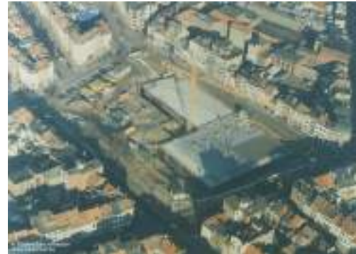
Luchtfoto tijdens renovatiewerken aan het plein, 05/02/2000, Coolens, Guido, Gazet van Antwerpen
