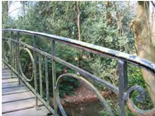
Figuur 2.2.1.d Hekwerk brug in slechte staat.
