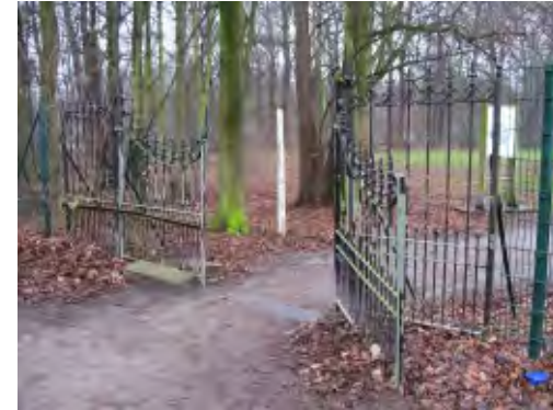
Figuur 4.7.3 Toegangspoort Vogelzang aan de Middelheimlaan, dringend toe aan een opknapbeurt.
