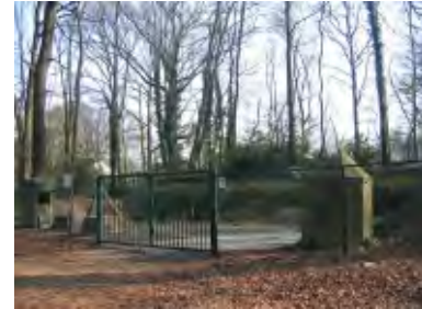
Figuur 2.1.2.3 SK1 bunker.
