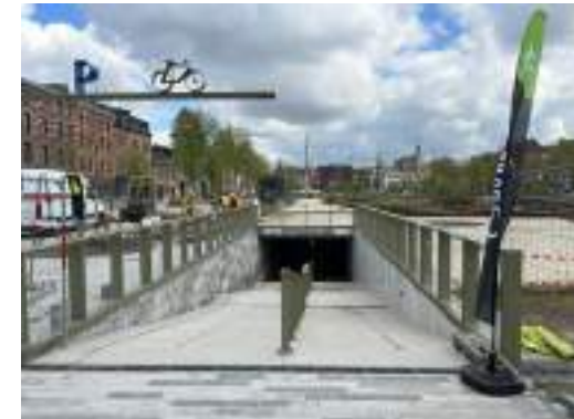
Referentie inrit fietsenstalling zuidpark, Antwerpen
