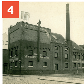
4 Brouwerij Cordemans Borrewaterstraat (ter hoogte van nr 123)
