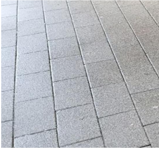
betonstraatsteen met toplaag in natuursteengranulaten
